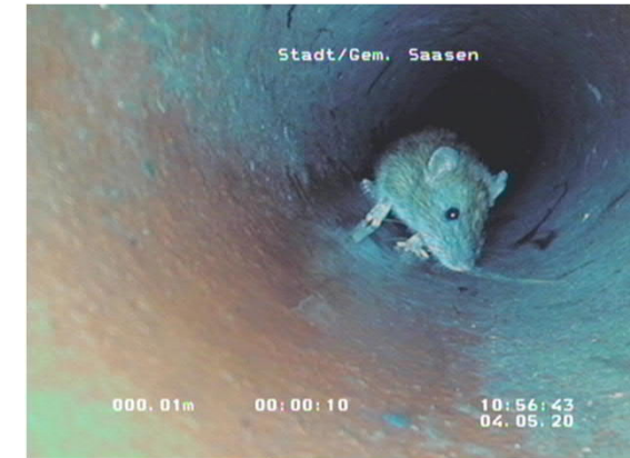
Foto-Nr. 708 0,0m 00:00:10 Ratte im Anschluss, Anzahl 1, Pos. 06
