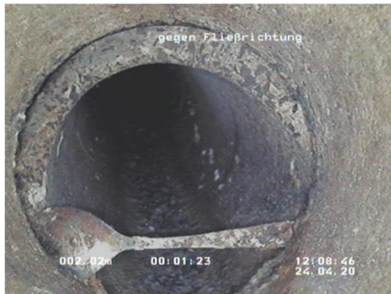
Foto-Nr. 521 2,0m 00:01:23 Hindernis eingekleimt in Rohrverbindung, im Verbindungsbereich, Querschnittsred. 30%, Pos. 04-08, Löffel
